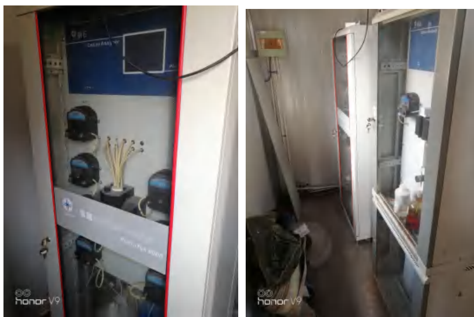
图 3.4.2-1 新亚公司废水在线监测仪器
