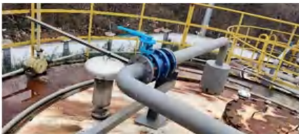
储罐呼吸口废气收集方式示例图
