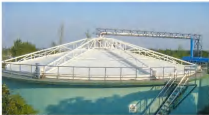
污水处理池加装反吊膜实例图
