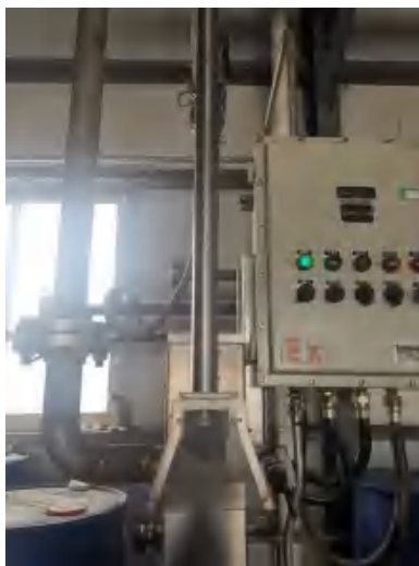
图 3.3.2-2 灌装区集气罩收集废气
