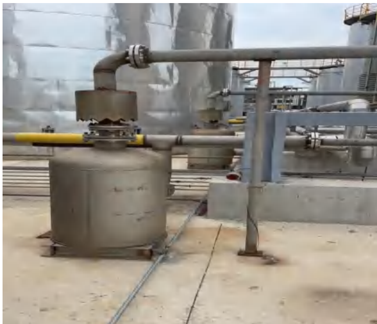
图 3.3.2-3 现有储罐区锯齿形集气罩
